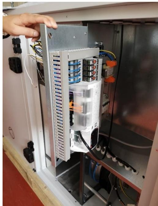
Abbildung: Regelungsblech aufgeklappt
